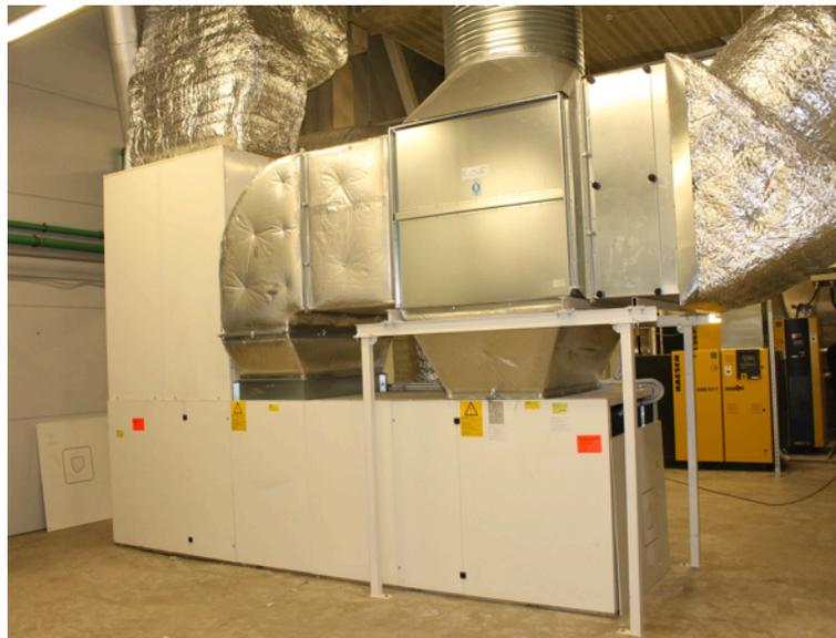
Вентиляционные агрегаты способны работать на лёгком жидком топливе, природном газе (G20 метан, G30 бутан, G31 пропан). Согласно европейской директиве по газу на генераторы установлены исключительно горелки с сертификацией CE с соответствующим сертификатом, выданным официальным разрешительным сертификационным органом.
